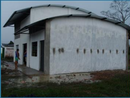
Laboratório em fase final de construção
