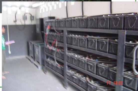
banco de baterias - 115,2 kWh
